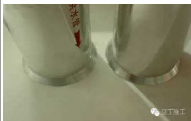
管道根部处理
