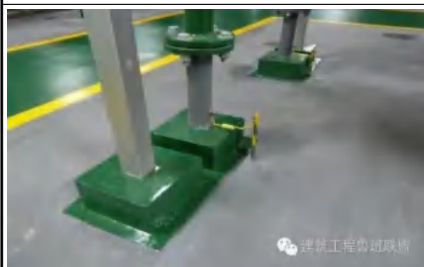
支架、管道根部混凝土护墩
