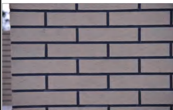
仿石喷涂墙面砖表面洁净，缝宽、深浅一致
