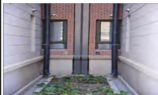
变形缝两边均设置沉降观察点
