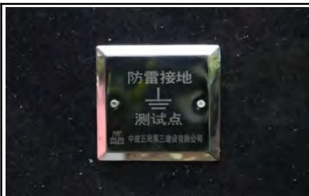
防雷接地测试点设置合理，做工精美
