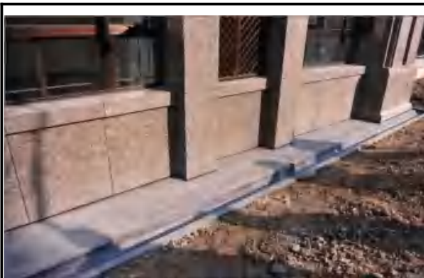
散水坡与墙面设置伸缩缝、密封胶填嵌密实
