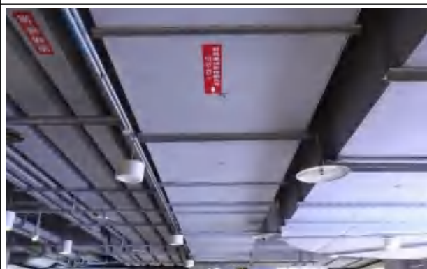
风管接口平直、连接严密
