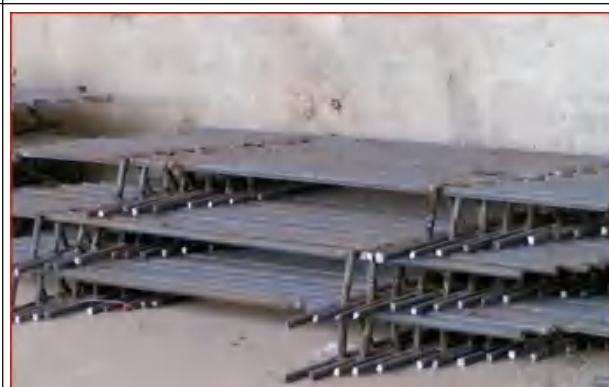
楼板钢筋马凳加工尺寸准确
