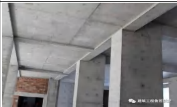
主体结构混凝土效果
