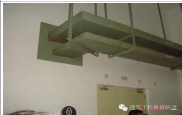
桥架穿墙时的护板收口做法
