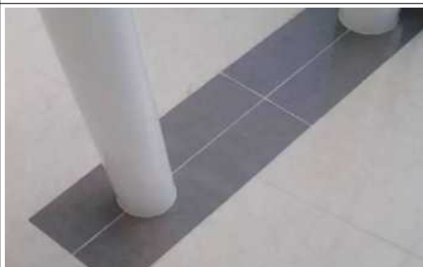
地砖及管道接缝处理
