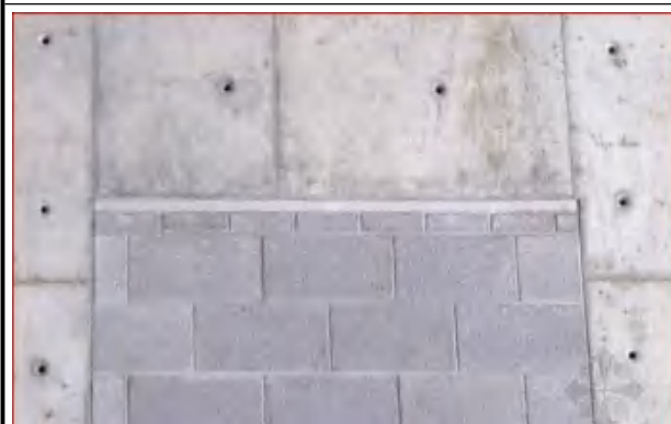
填充墙后塞口采用膨胀剂细石混凝土填塞
