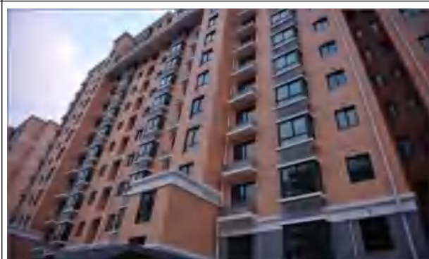
涂料外墙表面平整、色泽一致 阴阳角垂直、分色清晰
