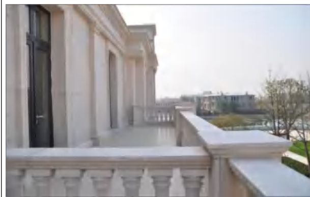
石材套割精确，表明平整光洁、色泽均匀
