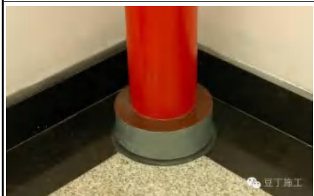
管道根部处理
