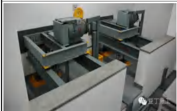
电梯机房内洞口收口
