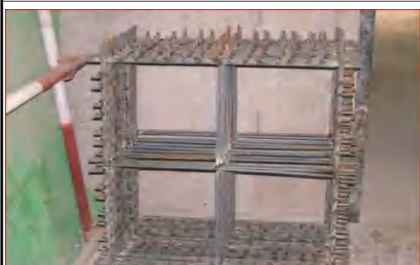
柱筋定位框
