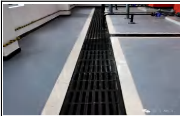
设备房排水沟
