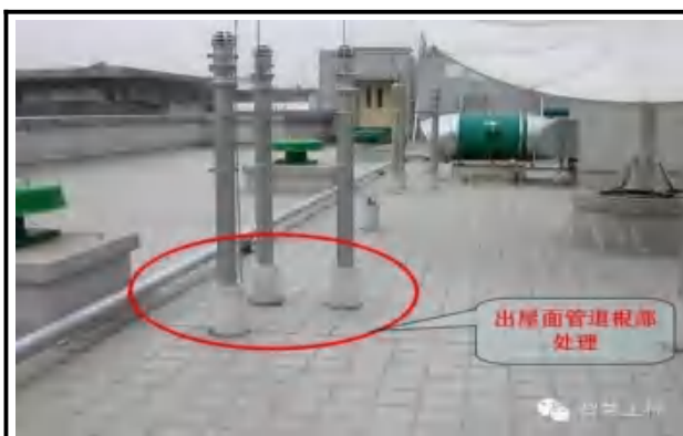
管道根部处理
