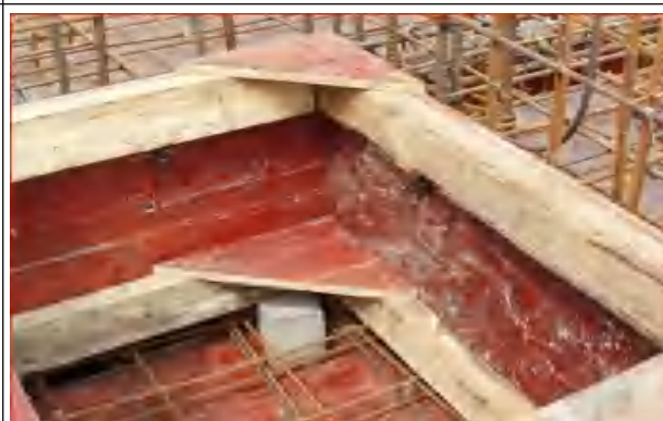
吊模位置采用同强度、等厚度的混凝土垫块控制， 确保吊模不下沉
