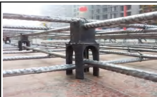
板筋垫块、马凳安装
