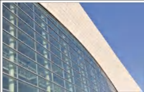
幕墙线条流畅，封胶整齐、饱满
