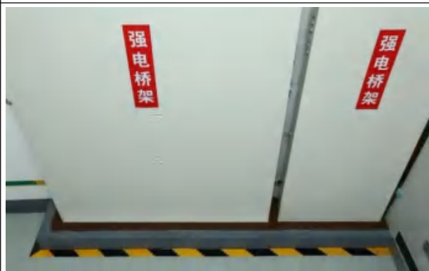
桥架防火封堵
