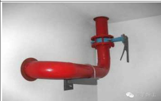
管道穿墙、板根部收口
